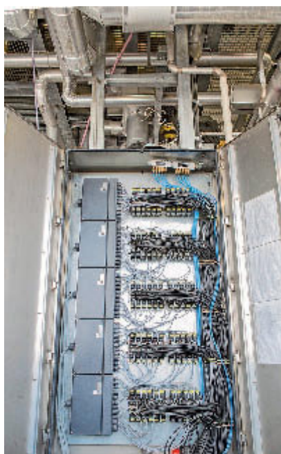
Die bisherige, konventionell verdrahtete Lösung brauchte mehr Platz, ist nicht hot-swap-fähig und ist aufwendiger verdrahtet
