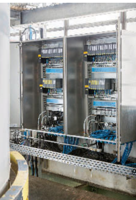
Die neue, standardisierte Lösung kombiniert sicherheitsgerichtete und nicht sicherheitsgerichtete Ventile auf einem Ventilblock
